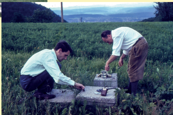
Der Beton-Sockel für das Newton-Teleskop; rechts Paul Ruckstuhl an der Arbeit
