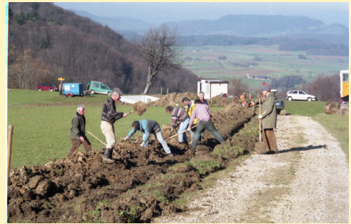
Rohbau – Strom und Telefonkabel verlegen
