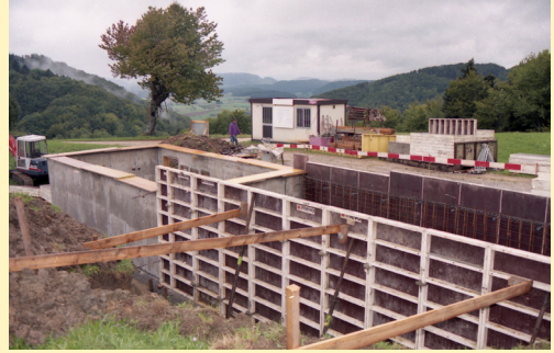
Aushub und Fundament – Rohbau Sternwarte
