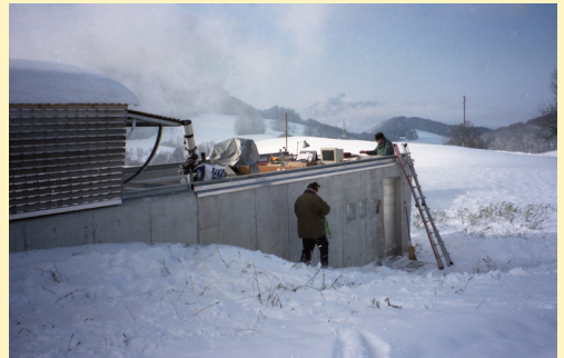
Arbeiten im tiefsten Winter – Montage der Bürstendichtungen
