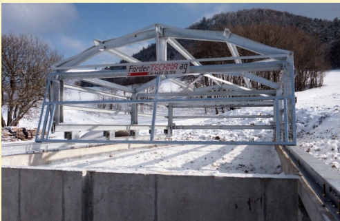
Dachkonstruktion – Montage Fassadenverkleidung
