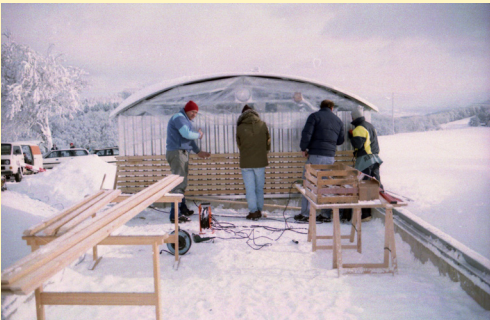
Holzfassade im tiefen Winter – Fronarbeiter schneiden Lächenlatten.
