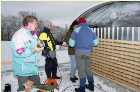
Arbeiten im tiefsten Winter – Montage der Bürstendichtungen
