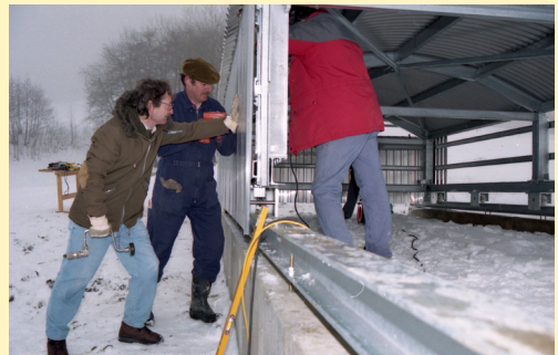
Dachkonstruktion – Montage Fassadenverkleidung
